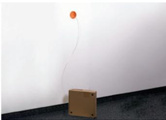
Stellen Sie nun die Kartonbox mit der Öffnung nach oben auf den Boden und ziehen Sie das Kabel beim Einziehen direkt aus der Kartonbox. Wenn Sie beim HAK angekommen sind, lassen Sie die restliche Überlänge (oder mindestens 2 Meter) bitte einfach liegen.
