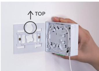
Entnehmen Sie aus dem Karton die Montageplatte, die von der Rückseite der OTO-Box abgenommen werden muss, sowie das Befestigungsset und montieren Sie die Montageplatte an der Wand.
