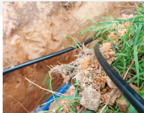
Abb.: Verlegung des Schutzrohrs
