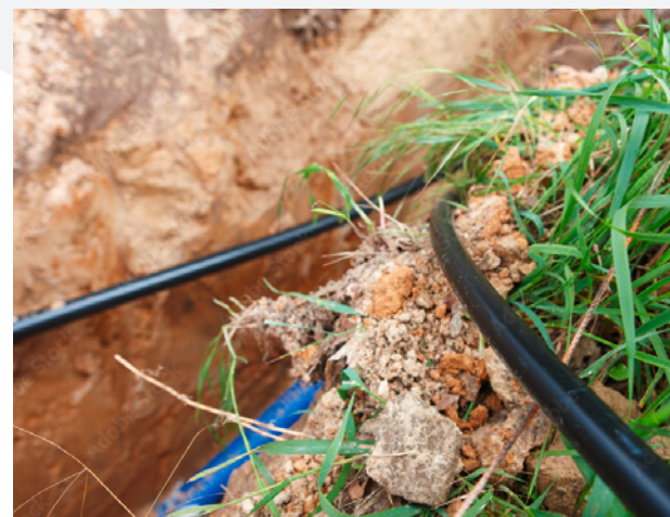
Abb.: Verlegung des Schutzrohrs
