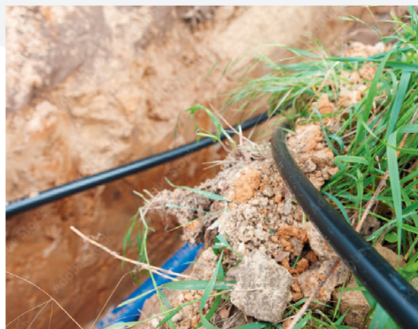
Abb.: Verlegung des Schutzrohrs
